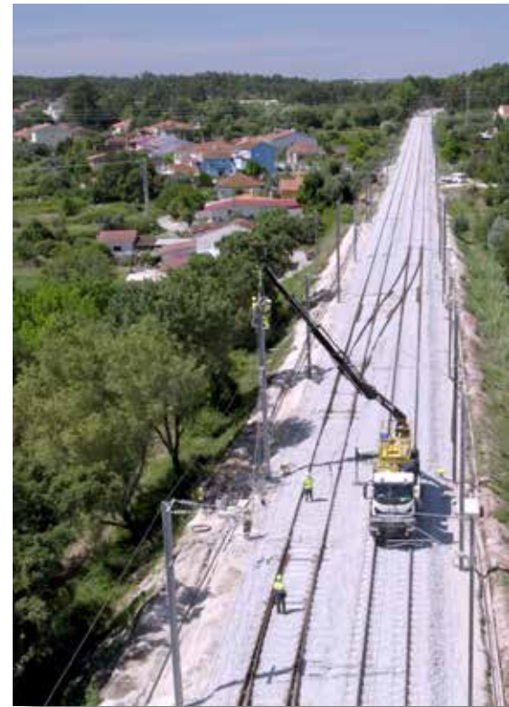
Renovação da Estação da Pampilhosa, Portugal
